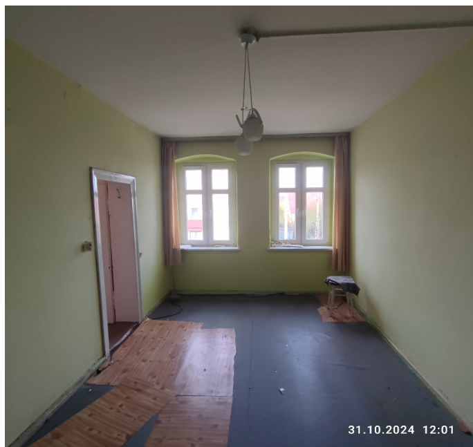
Zdjęcie lokalu do remontu
