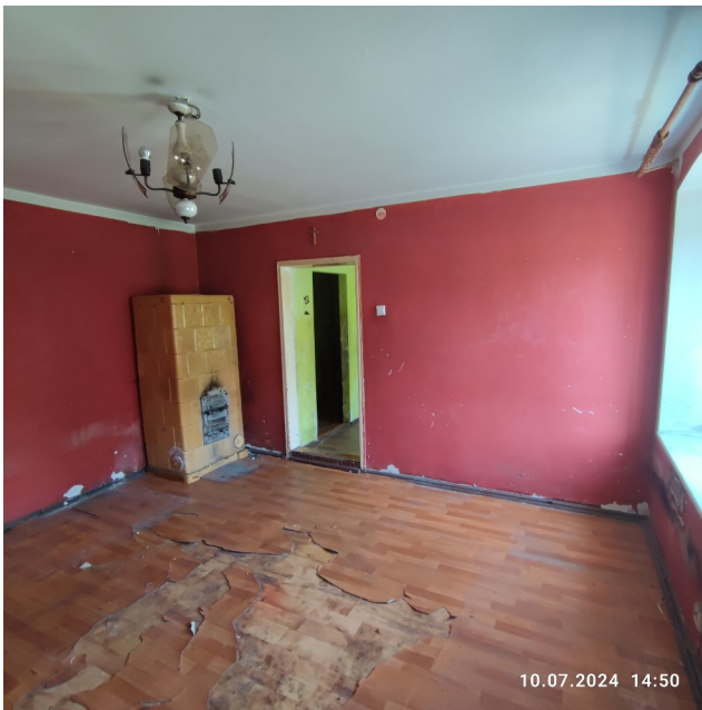
Zdjęcie lokalu do remontu
