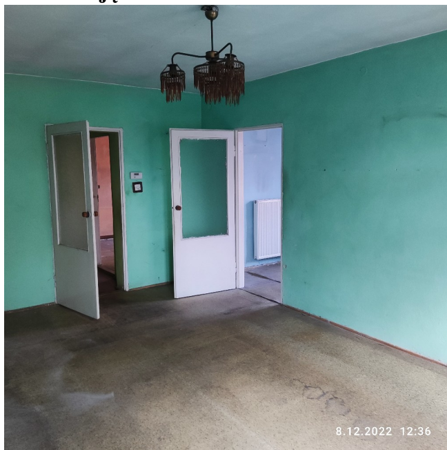
Zdjęcie lokalu do remontu
