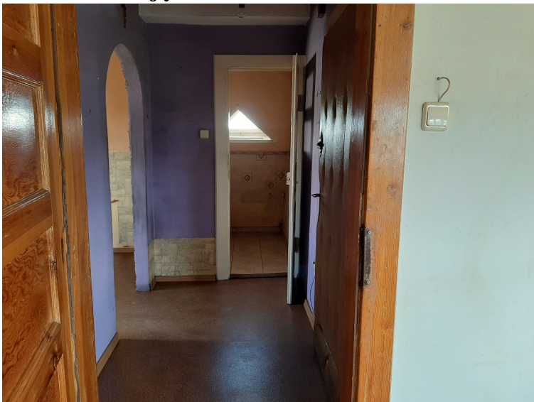
Zdjęcie lokalu do remontu
