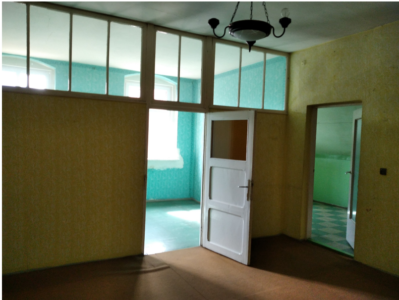
Zdjęcie lokalu do remontu
