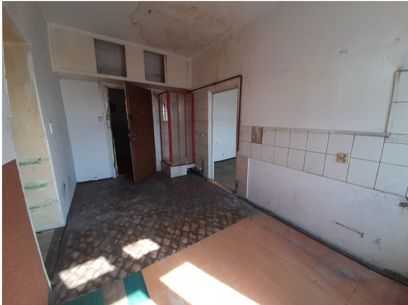
Zdjęcie lokalu do remontu
