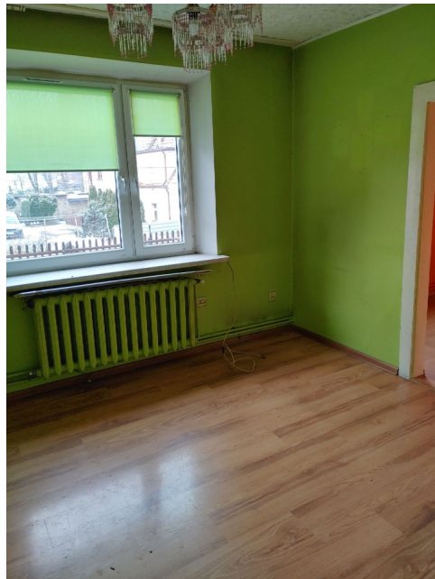
Zdjęcie lokalu do remontu
