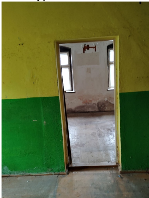
Zdjęcie lokalu do remontu
