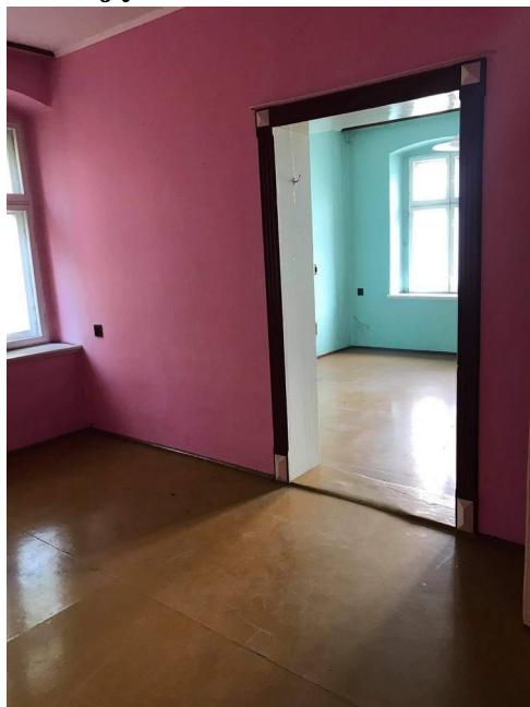
Zdjęcie lokalu do remontu
