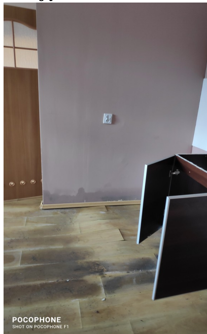
Zdjęcie lokalu do remontu
