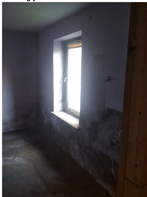
Zdjęcie lokalu do remontu
