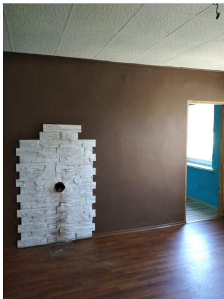
Zdjęcie lokalu do remontu
