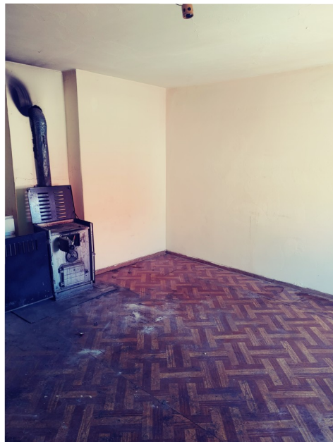
Zdjęcie lokalu do remontu
