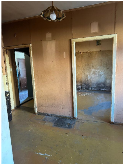
Zdjęcie lokalu do remontu
