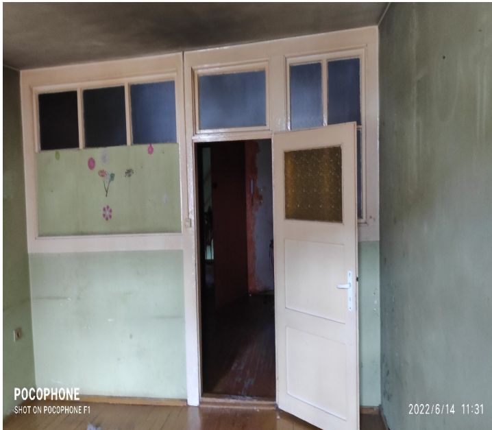
Zdjęcie lokalu do remontu
